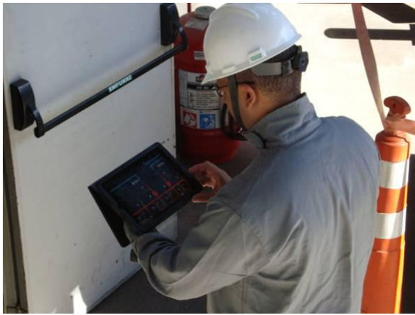
Figura 11 – Técnico verificando TAP do transformador
