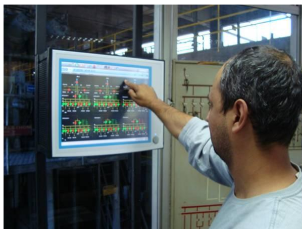
Figura 3 – Técnico verificando sinalizações de 20kV
