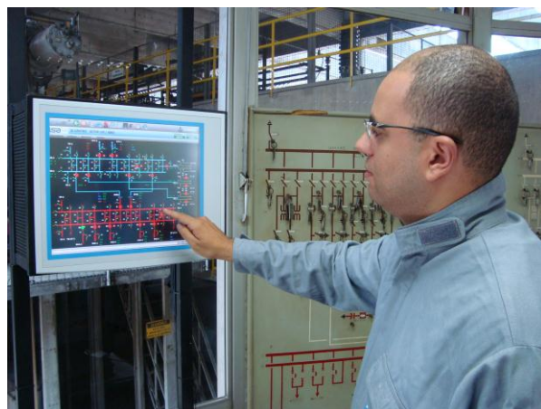
Figura 5 – Consulta do diagrama unifilar 230/88kV
