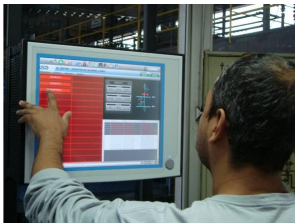
Figura 4 – Técnico inspecionando alarmes correntes
