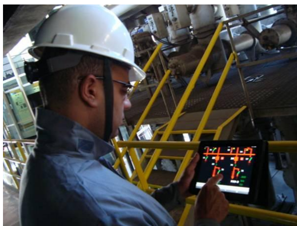
Figura 9 – Verificações no unifilar após manobras
